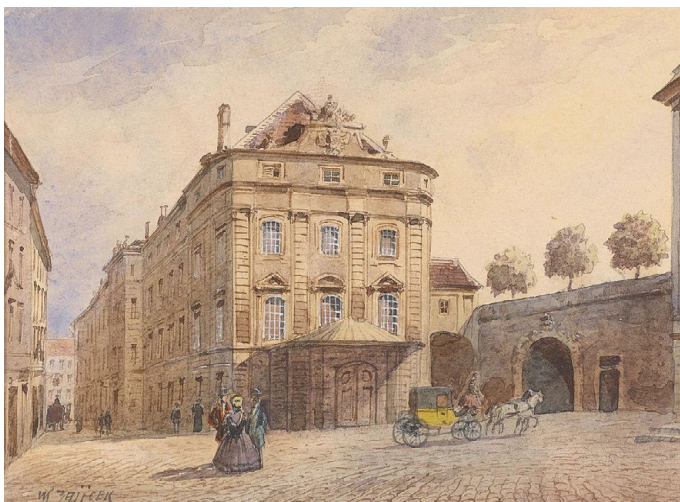
Neubau des zerstörten Kärntnertortheaters
